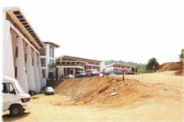
वलियमला में नए परिसर के निर्माण कार्य में प्रगति
